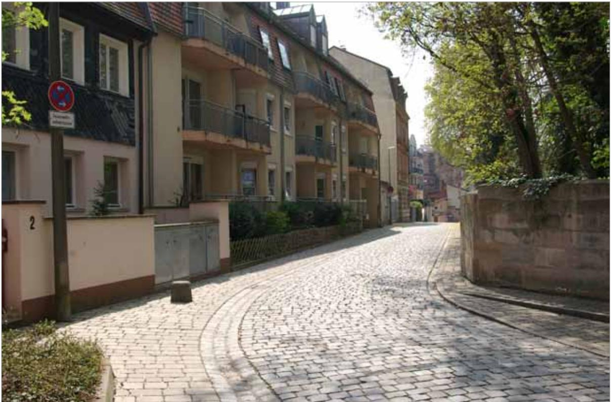
Neu eingebauter Natursteinpflasterbelag nach der Sanierung
